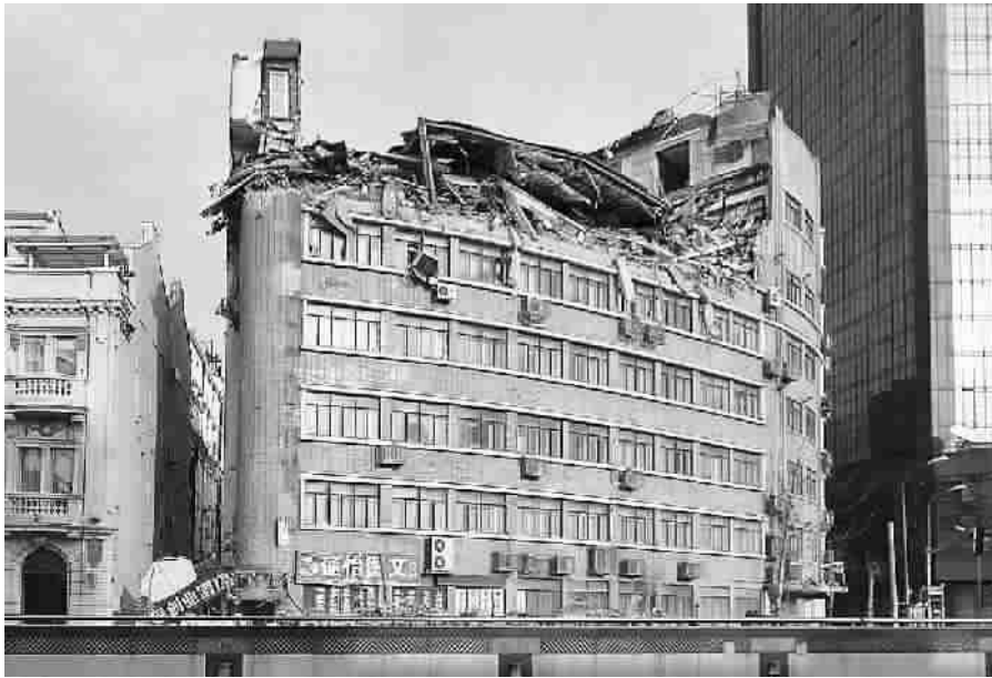
■ 四川大楼顶层一片废墟
