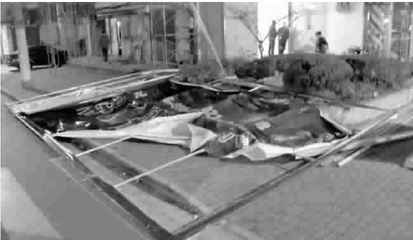
■ 广告牌砸到高压线后倒地
