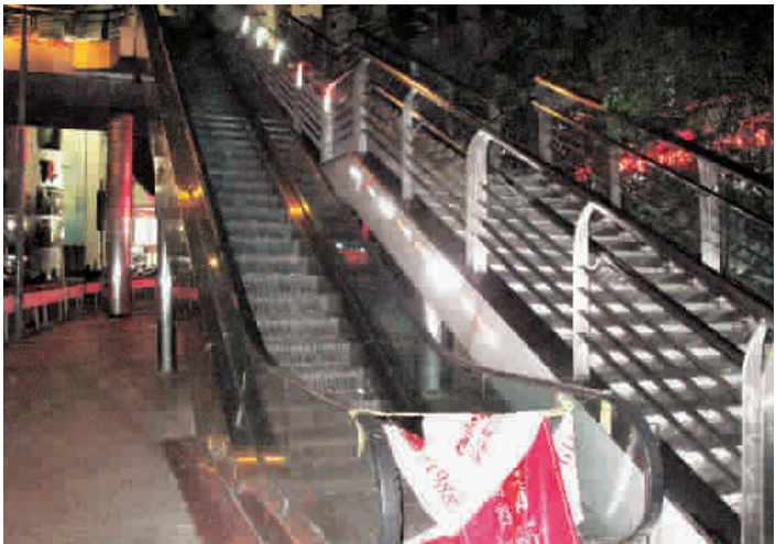
■ 徐家汇天桥天钥桥路处上下口被封
