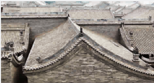
■ 山西平遥古城民居,传统民居是平遥古城的重要组成部分,建筑布局严谨,轴线明确,古朴的砖瓦墙典型明清建筑的特色
