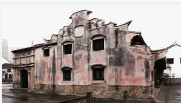
■ “修旧如旧”的台州椒江海门老街,被誉为是百年前的上海南京路,为保存老街的古味,改造时先用相机拍摄留档,随后拆开清洗再物归原处
