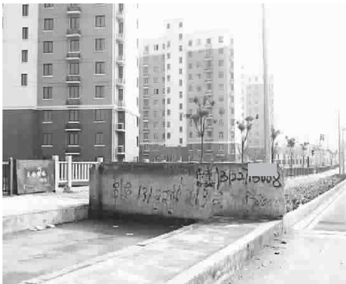
■岗亭东侧的非机动车道被一道高约1.5米的砖墙完全堵住 黄艳如 摄
