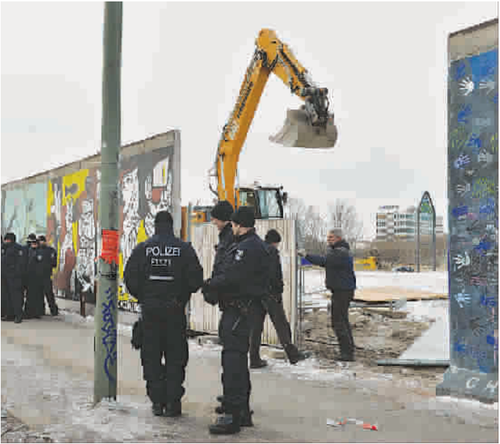
德国首都柏林市施普雷河岸边著名的柏林墙“东边画廊”27 日被拆掉部分墙体,在 1300 米长的画廊上留下 6 米左右空隙,为河岸豪华公寓施工“清道”,引发柏林市民强烈抗议 图 IC
