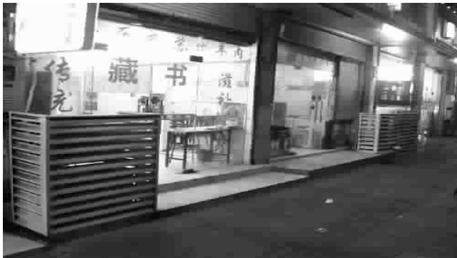
■ 空调外机违规安装
