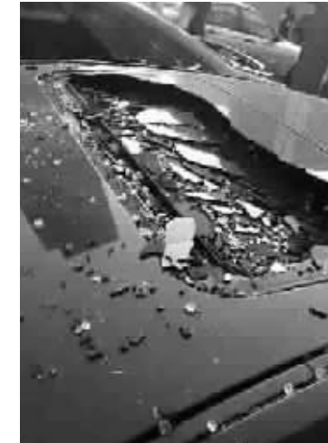
■ 轿车车窗被坠落的幕墙玻璃砸坏
