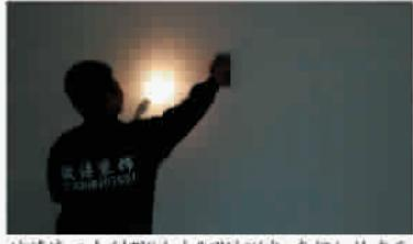
波涛漆工会利用“小太阳”的刷光，来进行检查和打磨批底子的墙面，以保证每一个施工环节。经过这样精细打磨后的墙面平整度将大大的提升，保证了以后强光照射下来也不会出现瑕疵。
