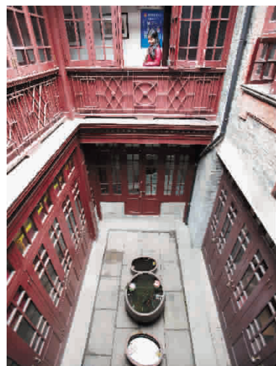
■ 张园石库门住宅内天井
