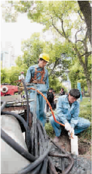
通过管子还可观察树下水位,水多了可抽出,干了可以浇灌
