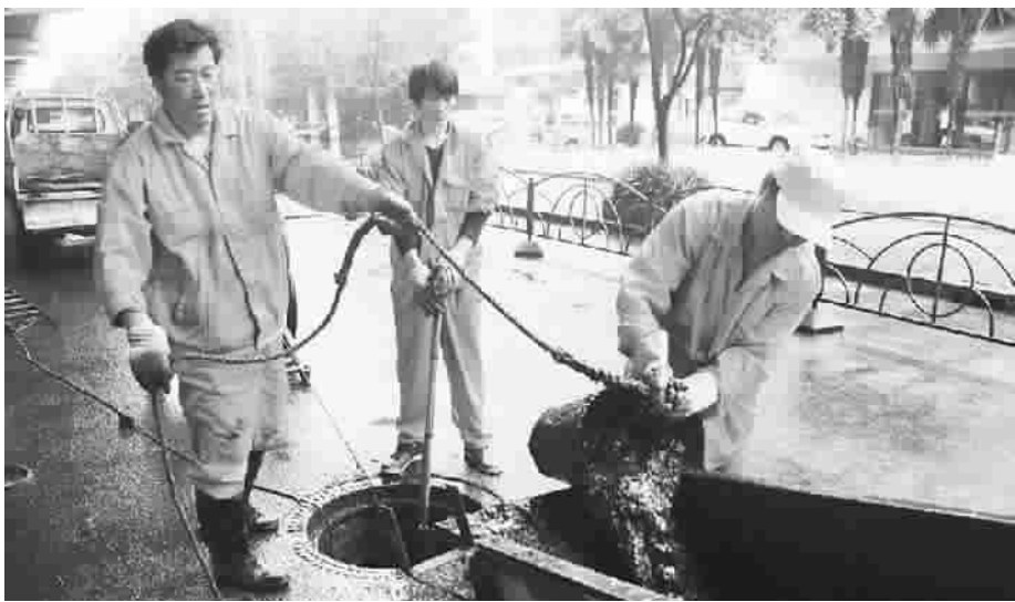
清淤防汛 为了让汛期中的强降雨积水能快速退去,市政养护部门连日来加紧对马路的窨井淤泥进行疏通清除,确保下水道的畅通。图为杨浦区市政养护工人在宁国路上清除沿线窨井淤泥 肖健 摄影报道
