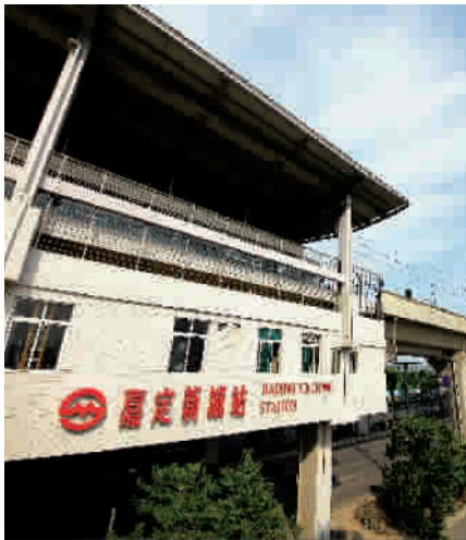
■ 轨道交通 11 号线嘉定新城站
