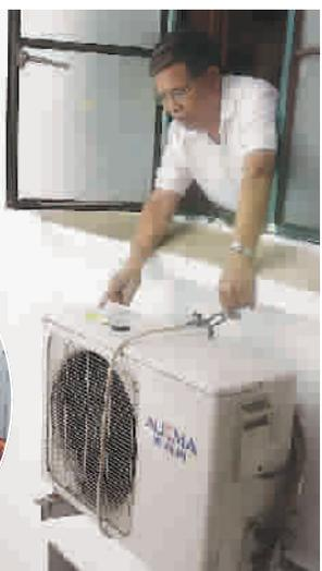
■ 加固空调外机的钢丝绳系在墙壁的螺丝上 本报记者 陈意俊 摄
