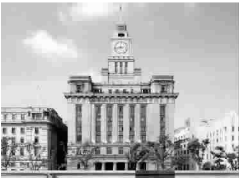
外滩13号 (插图:张雪飞 摄) 昨天:海关大楼 今天:海关大楼 建成年代:1927年 建筑风格:有节制的古典主义 建筑师:公和洋行 地址:中山东一路13号
