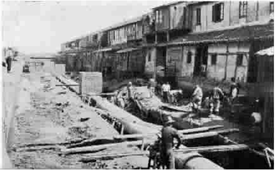
▲ 华界陆家浜路铺设下水道
