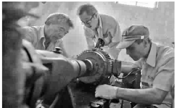
■ 闸北区房屋维修应急中心的员工正在维修水泵
