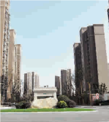
■ 汇丰凯苑(区属动迁安置房)
