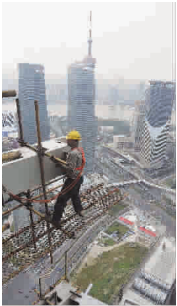
■ 上海中心 54 层、离地 255 米处,工人们正埋头苦干
