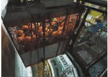
■ 工作电梯带着施工人员前往高处施工
