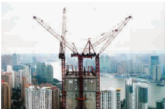
■ 国内首次采用四台巨型动臂塔式起重机集中用于上海中心大厦钢结构施工, 这是超高层建筑施工又一重大技术创举。
