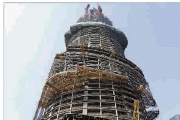
■ 幕墙支撑施工升降平台
