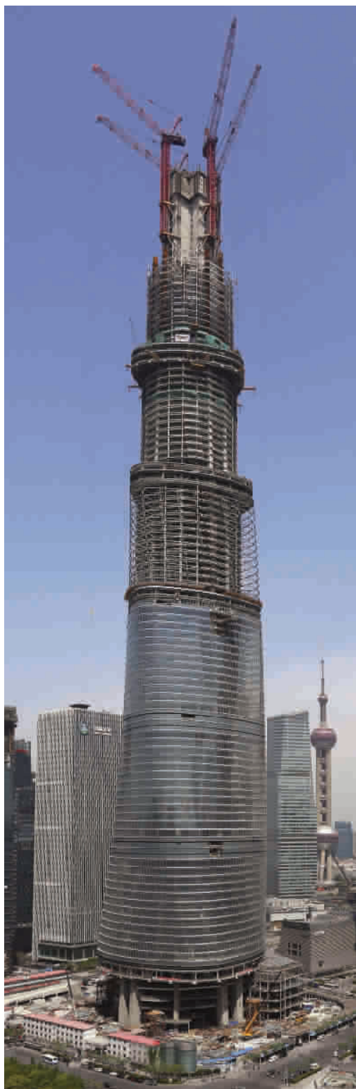
■ 上海中心大厦 580 米结构封顶
