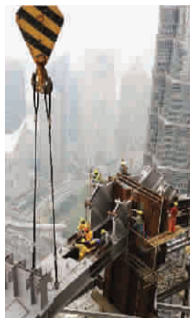
■ 环形带状桁架空中对接
