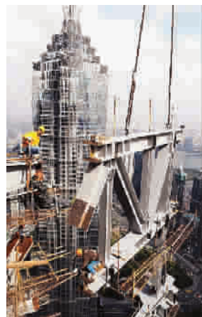
■ 超高空悬挑梁安装
