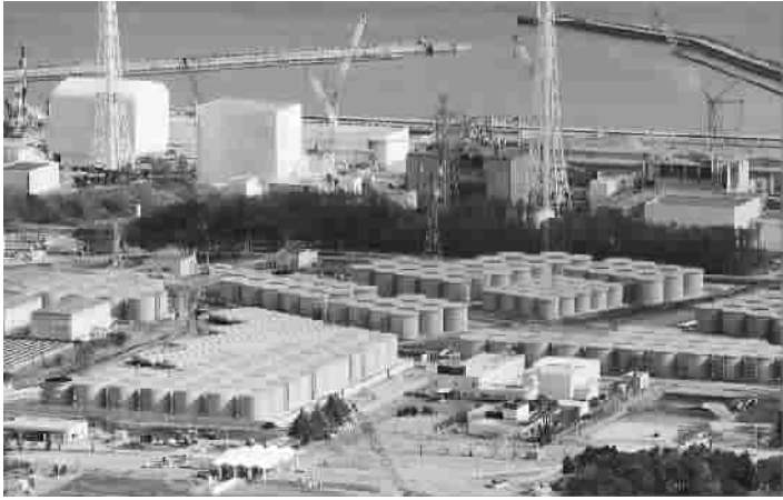
福岛第一核电站储水罐发生泄漏
