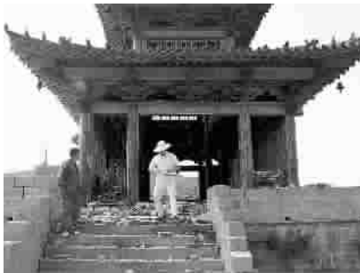
▲ 四川广元昭化古城阮仪三主持重修的城楼在汶川大地震中仅山墙倒塌,木构架无损伤
