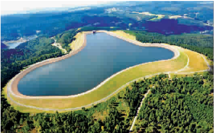
■德国最大的 Goldisthal 抽水蓄能电站也面临关闭的危险 本版图片 GJ
