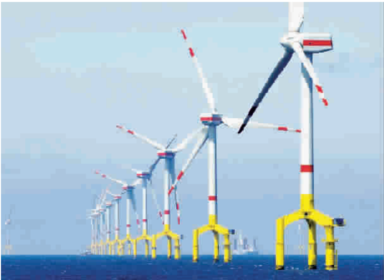
■位于北海上的海上风电场的风力涡轮机还没联入电网,目前只能空转以防止生锈
