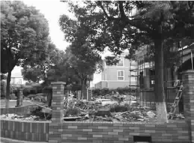
■ 377号拆墙重建,扩大庭院面积
