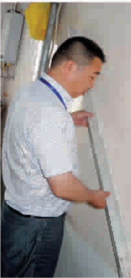
波涛装饰总经理范杰亲自测量墙面的平整度之一。
