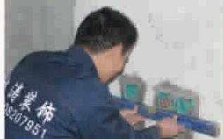
正在测量的这位监察人员,检测的是波涛装饰自成一格的从难从严施工工艺——同一房间开关、插座的水平高度偏差保持在5mm之内,而强弱电的线盒之间距离不小于150mm。
