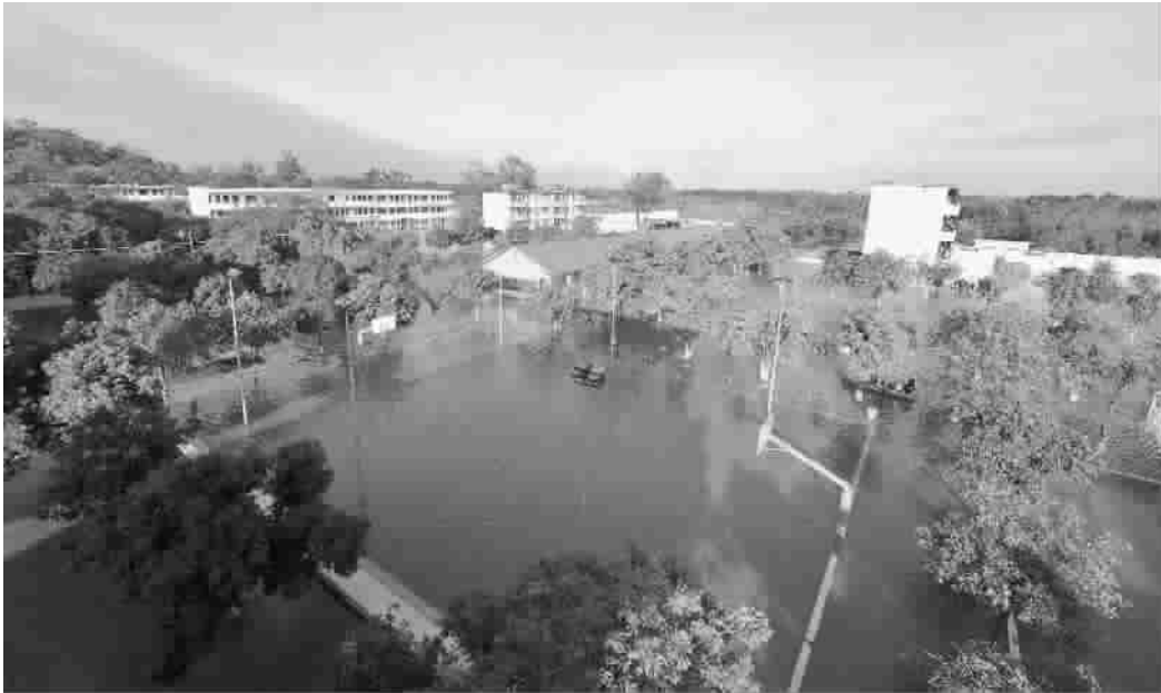
■ 昨天,广西贵港市覃塘区三里镇三里一中校园四面被洪水围困。为安全起见,学校师生被安排在二楼以上,暂不向外转移。目前天气晴好,校园内积水已开始消退
