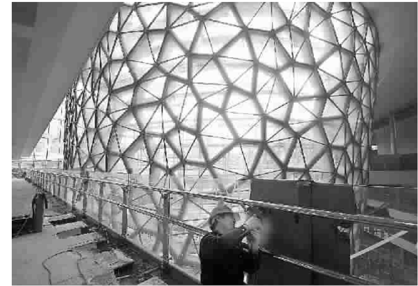
位于静安雕塑公园内的上海自然博物馆新馆，土建施工已基本完成，目前进行到内部装饰阶段，按计划明年将开门迎客。新馆地面以上有2层，地下包括夹层在内有4层，总建筑面积4.4万平方米。 本报记者 陈意俊 摄影报道
