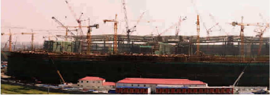
■ 由上海建工集团总承包的世界上最大的单体建筑——中国博览会会展综合体项目 图 TP
