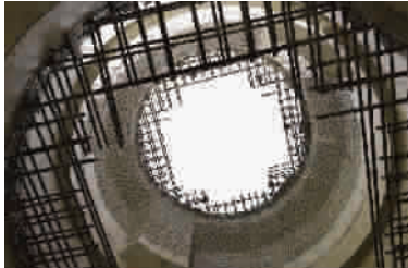
▲ 桥梁预制件中的螺旋线形
