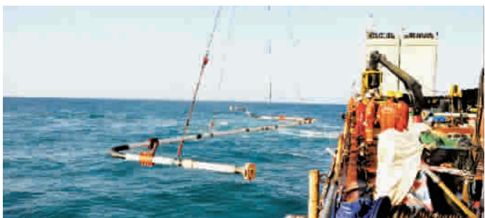
■ 水下连接器现场作业
