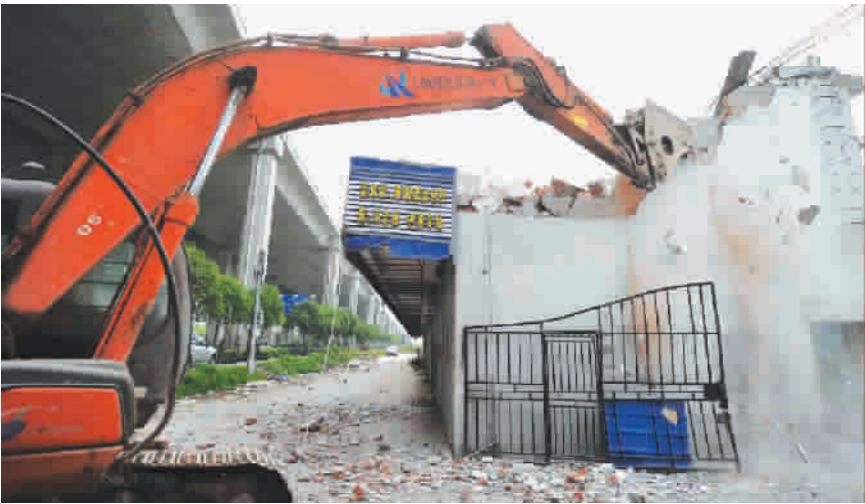
■ 今天上午,工作人员正在用专业设备拆除沿街违法建筑 本报记者 陈意俊 摄
