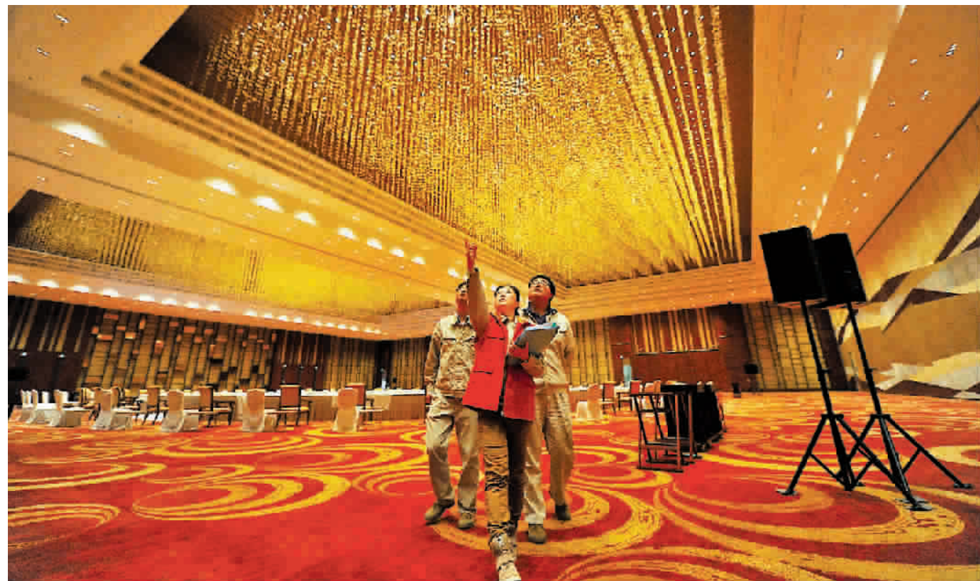
浦东公司在亚信场馆内调试用电设备
