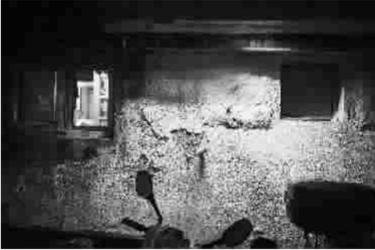
■ 自行车棚排水有故障,居民墙面进水起泡
