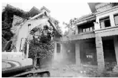
■“湖山在望”53号私建车库被拆除 本报记者 陈梦泽 摄
