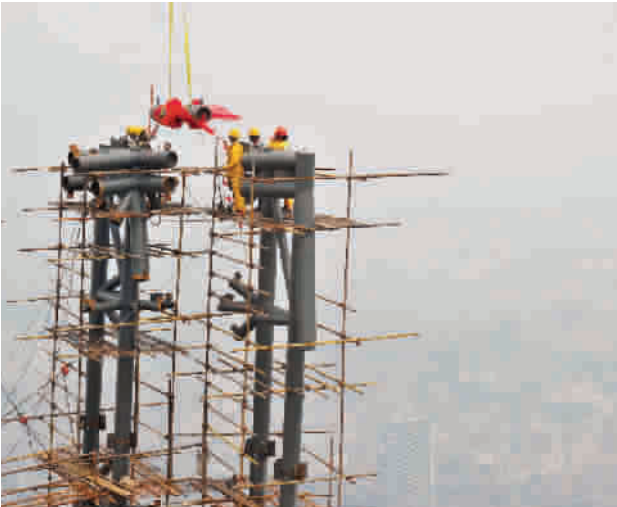
■ 最后一根鳍状桁架起吊到位 本报记者 刘开明 陈意俊 摄
