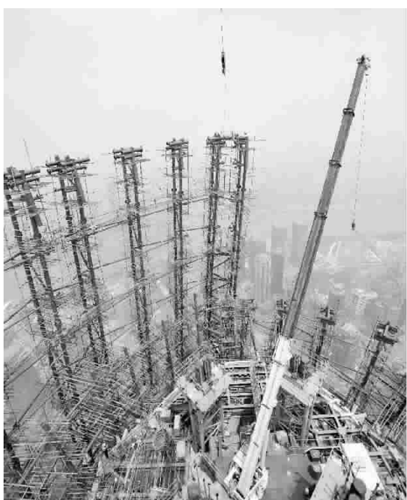
■ 上海中心大厦塔冠结构封顶现场 本报记者 陈意俊 摄
