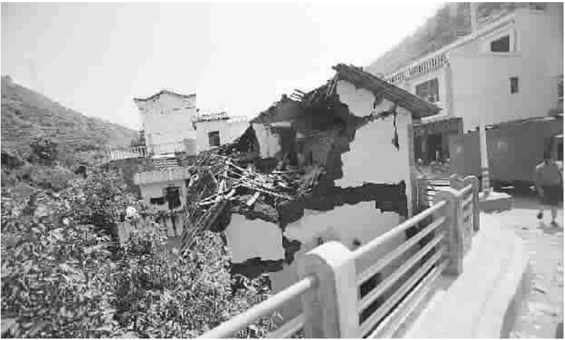
■ 龙头山镇路边随处可见倒塌的房屋
