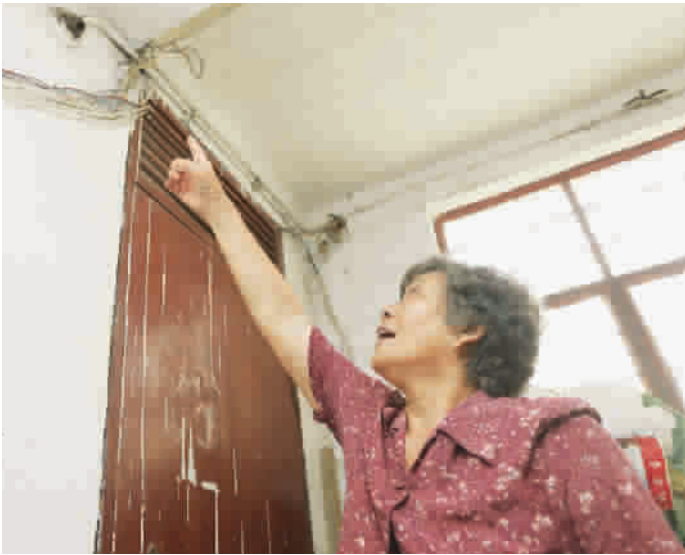
■ 堡镇中路398号楼道内感应灯缺失
