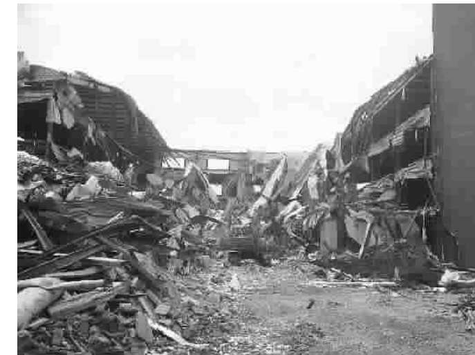
■ 正在拆除违法搭建的现场 金旻矣 摄
