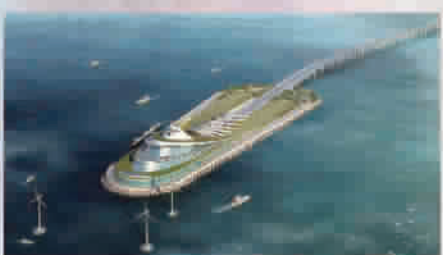
港珠澳大桥隧道主体工程
