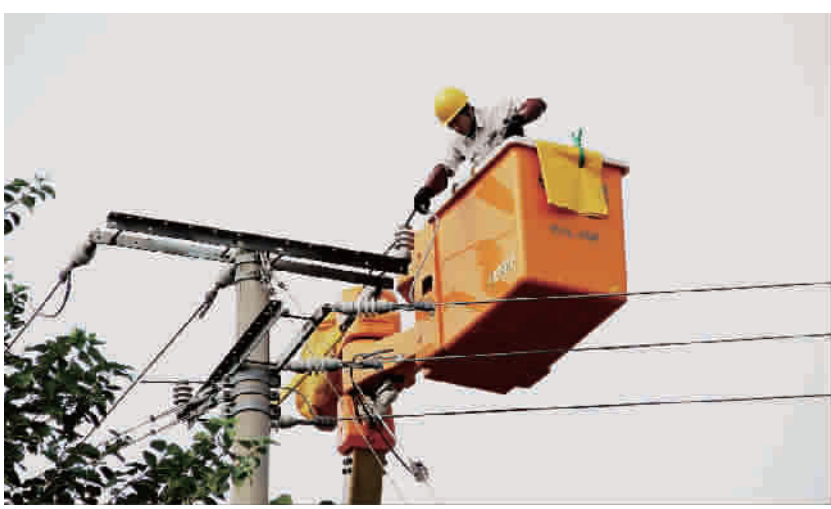
■ 工作人员在进行线路带电抢修
