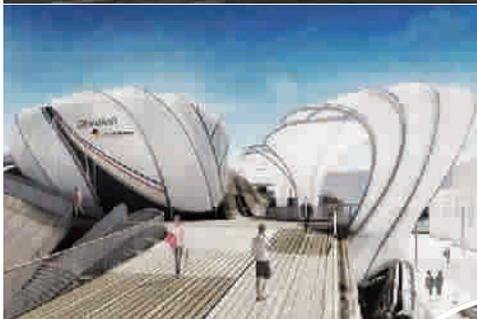
素融入其中，屋顶采用竹编材料覆盖，在意大利灿烂阳光照射下，折射出金色的光彩。对应米兰的日照轨迹，屋顶选择不同透光率的竹编面材，将自然采光引入室内。”演绎中国味道，高张天人合一，一切都让艺术唱主角，这也与米兰的艺术街头交相辉映。
