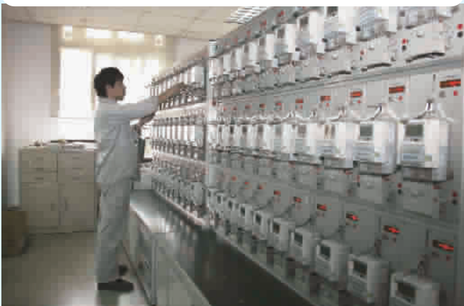
■ 检定人员正在进行电能表首次检定
