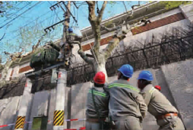
■ 电力人员正在实施配电网升级改造工程
