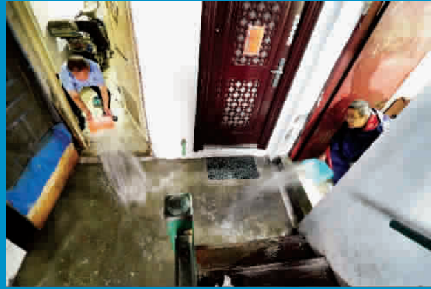
■ 内江一村雨水倒灌严重,物业帮居民家里排水 种楠 摄
