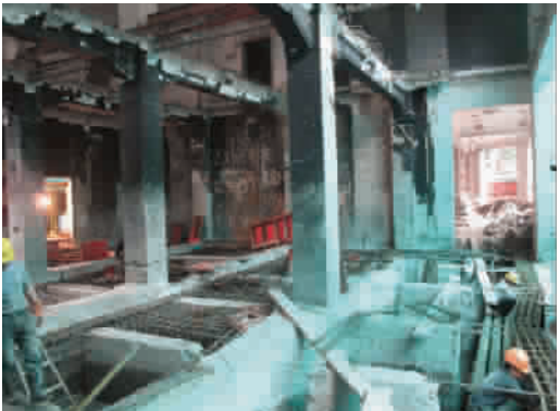
■ 正在改造的美伦大楼内部 本报记者 屠仕超 摄
