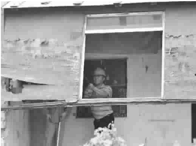
拆违工人拆除违法建筑
