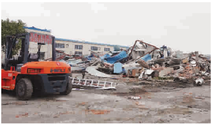
■ 挖掘机轰隆，违建厂房应声倒地 实习生 陈弋旻 摄
