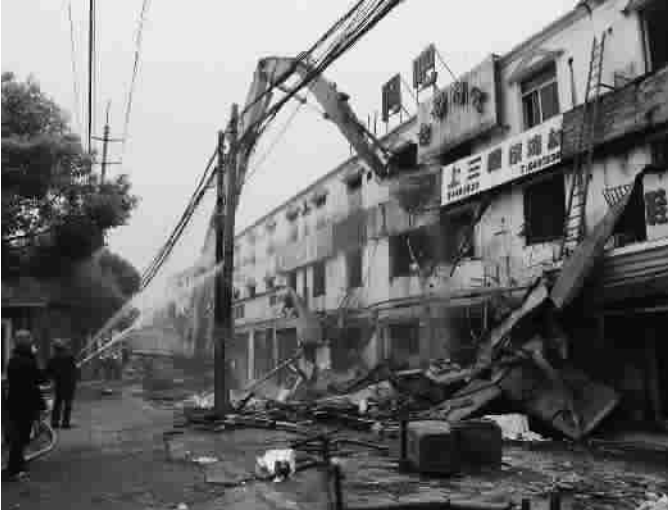
■ 挖掘机挥舞“铁臂”,一幢幢违法建筑瞬间化为乌有 马天璋 摄
